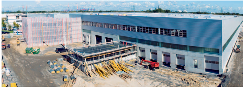
Sicht auf die Westseite der Halle 4: Hier wird zukünftig der Wareneingang des MWZ abgebildet
